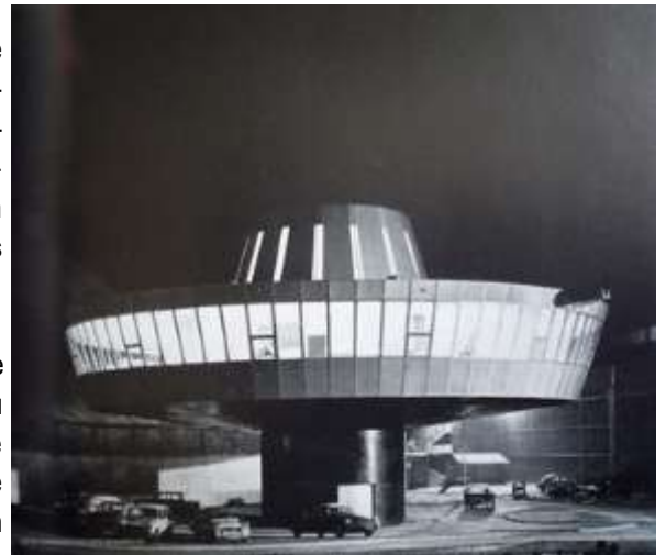
La "tour de contrôle" de la sucrerie d'Arcis
